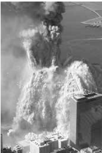
Einsturz des Nordtowers
