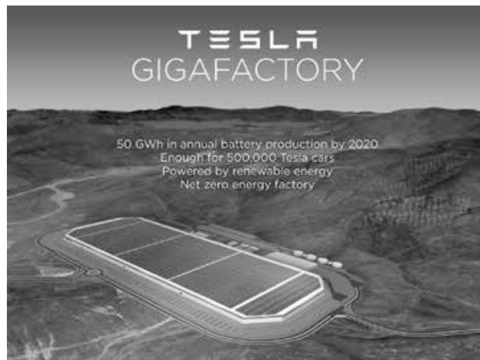
Grafik der im Bau befindlichen Gigafactory von TESLA.
