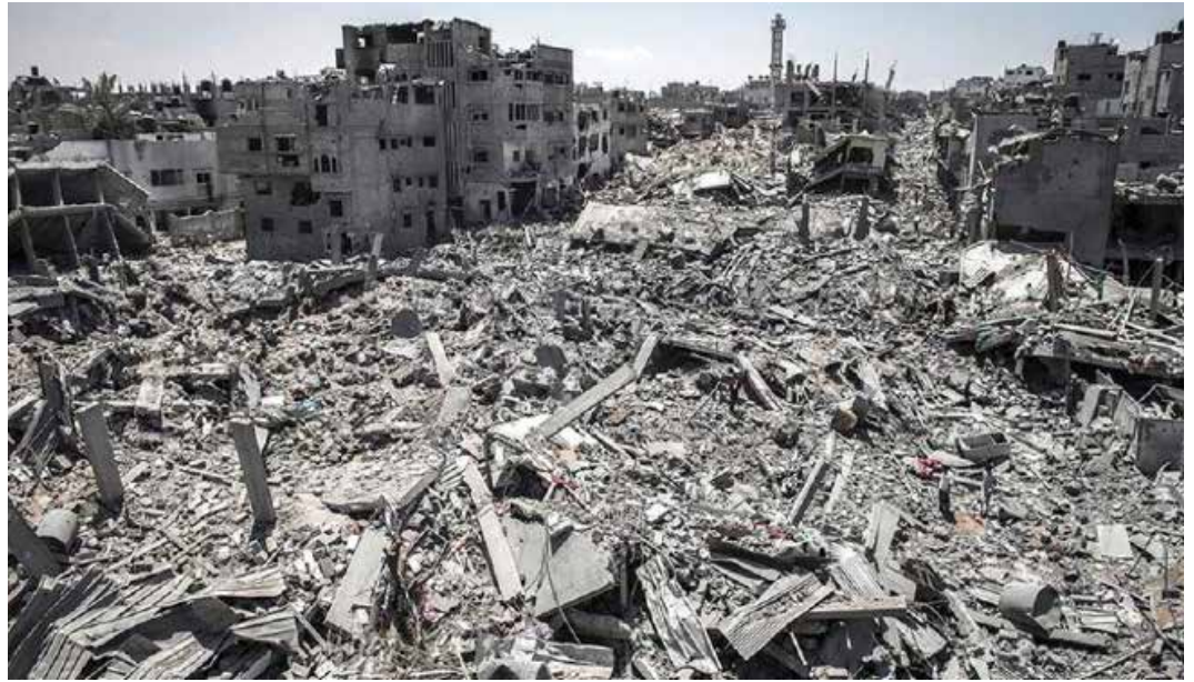
Gáza, 2014. 18 000 lerombolt ház. 100 000 hajléktalan. 3000 halott. 25 000 súlyosan sérült.
