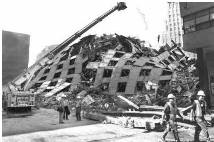
Das Gebäude 7 nach dem Einsturz
