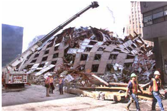
Das Gebäude 7 nach dem Einsturz
