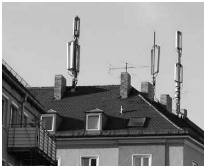
Mobilfunkantennen auf Wohnhausdach (Foto: Wikipedia, CC BY-SA 3.0)
