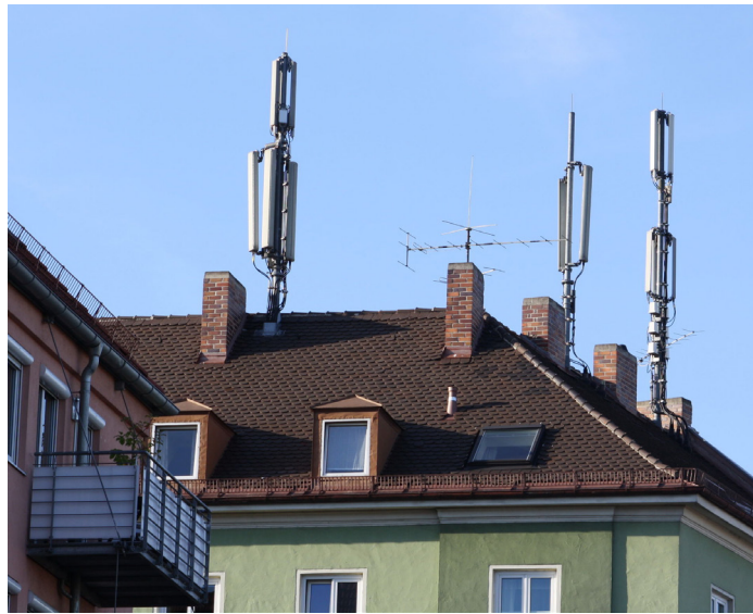
Mobilfunkantennen auf Wohnhausdach (Foto: Wikipedia, CC BY-SA 3.0)
