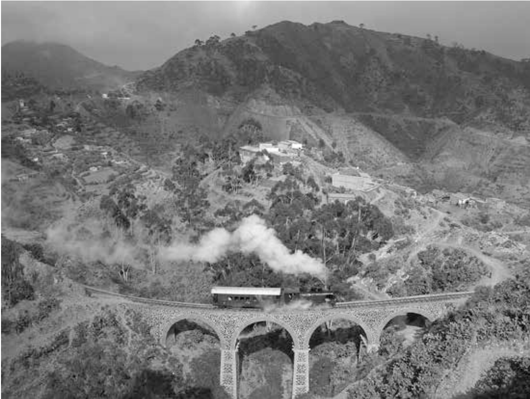
Eritreische Eisenbahn im bergigen Gelände zwischen Arbaroba und der Hauptstadt Asmara. (Foto: Optimist on the run, CC BY-SA 3.0)
