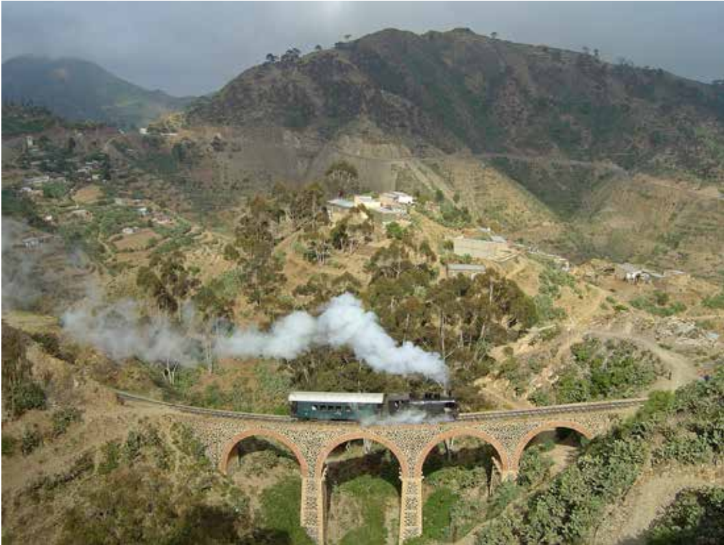
Eritreische Eisenbahn im bergigen Gelände zwischen Arbaroba und der Hauptstadt Asmara. (Foto: Optimist on the run, CC BY-SA 3.0)
