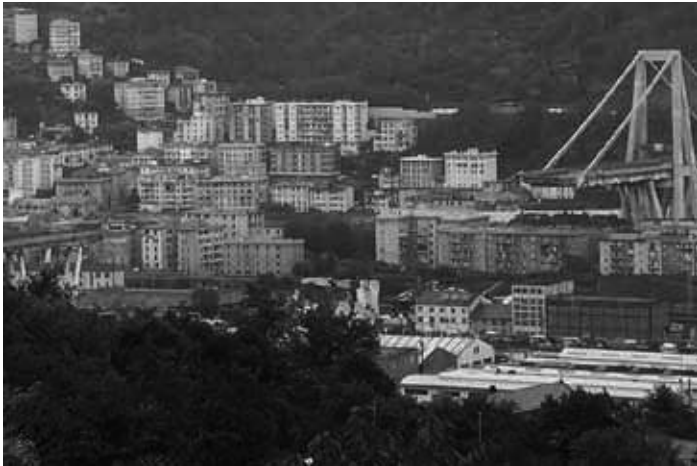
Ponte Morandi, anderer Name für den Polcevera-Viadukt, 2018 eingestürzte Autobahnbrücke in Genua. Quelle: https://de.m.wikipedia.org/wiki/Datei:Ponte_morandi_crollato_(cropped).jpg , Foto: Salvatore1991, Lizenz: CC BY-SA 4
