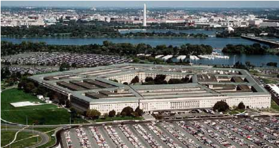
Das Pentagon; Sicht nach Nordosten mit dem Potomac River und Washington Monument im Hintergrund. Quelle: https://de.m.wikipedia.org/wiki/Datei:The_Pentagon_US_Department_of_Defense_building.jpg , Foto: DoD photo by Master Sgt. Ken Hammond, U.S. Air Force, Lizenz: gemeinfrei.
